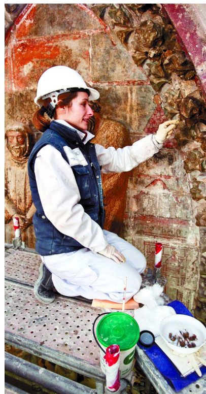
Trabajos de limpieza en la galería sur del claustro alto de la Catedral. Luis López Araico
